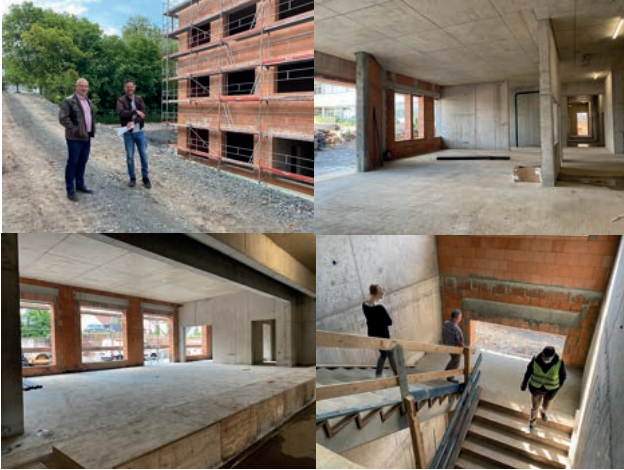
Baustelle von links nach rechts und oben nach unten: Steffen Schlüter mit Ralf Röckelein vom Landratsamt Haßberge, Blick in den Eingangsbereich, die neue Bühne (Mehrzweckraum), Treppenhaus
