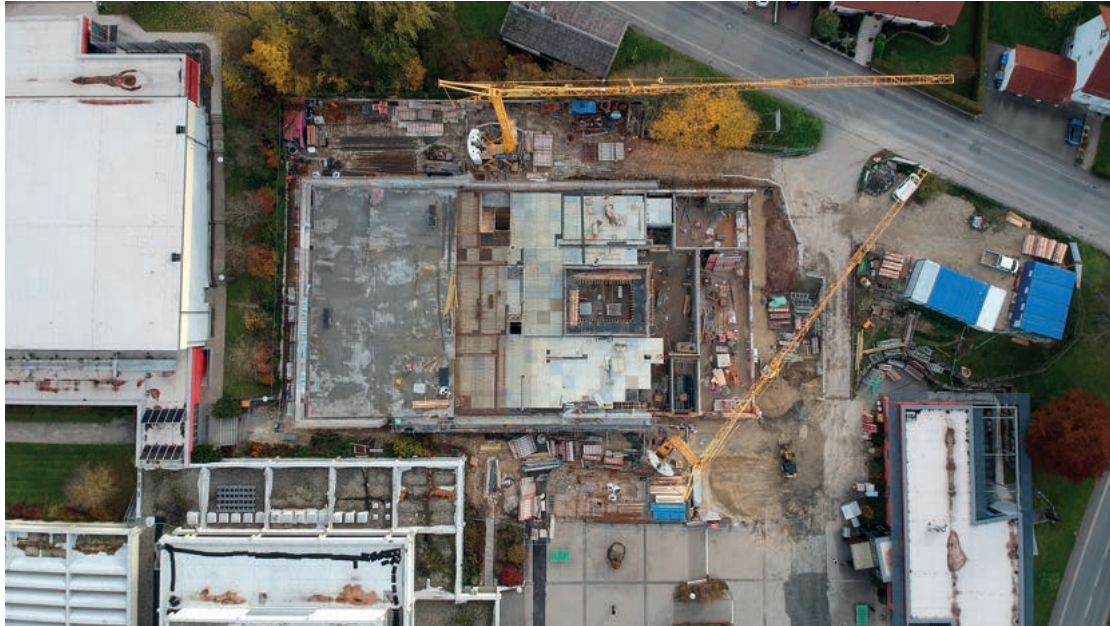
Baustelle des Neubaus, Drohnenaufnahme, November 2019
